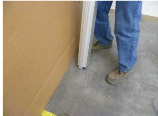
Nachdem die Pylone vorsichtig in die Wandhalterung geschoben wurde, ist mit einer Wasserwaage das Lotrecht zu prüfen.
