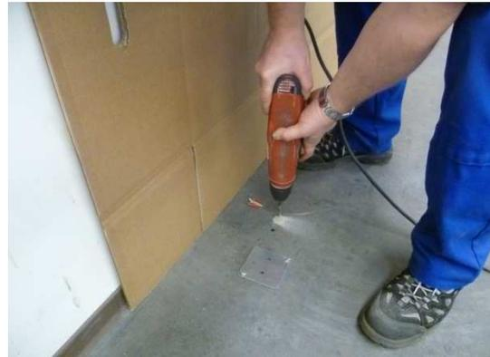
Der Wandhalter wird in einem Abstand von 100 mm von Oberkante Pylone bis Oberkante Wandhalter befestigt (214 cm bei Standardpylonenhöhe). Die kurze Seite des Schenkels ist nach innen zu montieren.
