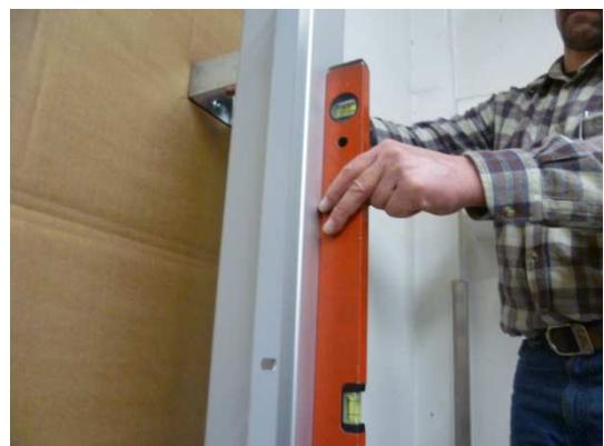
Nach Prüfung wird die die Pylone am Wandhalter befestigt.
