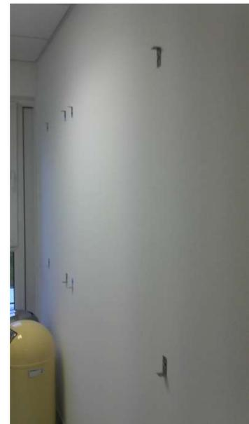
Die Projektionsfläche ist auf die unteren Winkel zusetzen und an die Wand zudrücken. Die oberen Winkel werden mit dem Hammer leicht auf die Aluminium-Umrahmung geschlagen und verschraubt. Zum Schluss werden auch die unteren Winkel mit der Umrahmung verschraubt.
