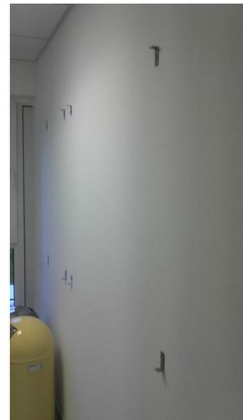
Die Tafel ist auf die unteren Winkel aufzusetzen und an die Wand zudrücken. Die oberen Winkel werden mit dem Hammer leicht auf die Aluminium-Umrahmung geschlagen und verschraubt. Zum Schluss werden auch die unteren Winkel mit der Umrahmung verschraubt.
