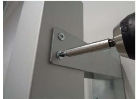
Das Montageplättchen zur Befestigung der vorderen Pylone wird zunächst an der hinteren angebracht. Dies geschieht nur auf der Innenseite mittels 2 mitgelieferten Pias.
