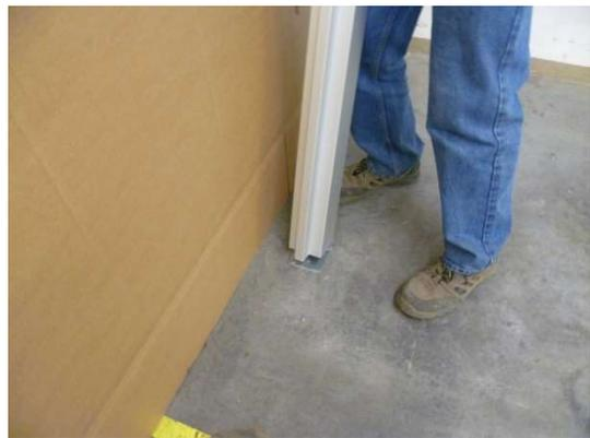
Bitte schieben Sie nun die Pylone vorsichtig in die Wandhalterung und überprüfen Sie mit einer Wasserwaage ob die Pylone lotrecht steht. Ggfls. die Wandhalterung lösen und so verstellen, dass die Pylone im Lot steht. (Beide Seiten überprüfen)
