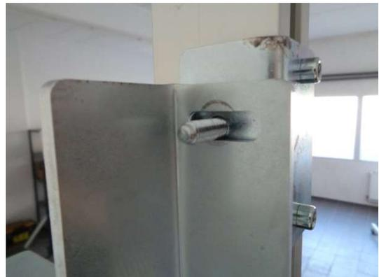
Die zuvor abgeschraubten 4 Sperrzahnmutter M8 mit Knarren-Ring-Maulschlüssel SW 13 aufschrauben und anziehen.
