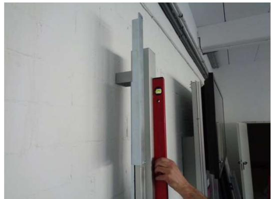
Nach Prüfung wird die Pylone am Wandhalter befestigt.
