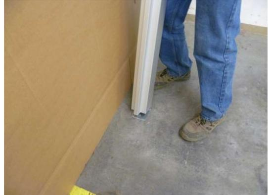
Nachdem die Pylone vorsichtig in die Wandhalterung geschoben wurde, ist mit einer Wasserwaage das Lotrecht zu prüfen. Ggfls. die Wandhalterung lösen und so verstellen, dass die Pylone im Lot steht. (Beide Seiten überprüfen)
