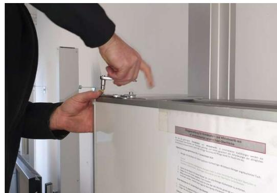
Beim Ausrichten der Tafelflügel ist darauf zu achten, dass Display-Außenkante und Flügel-Außenkante eine Linie ergeben. Ist das auf beiden Seiten der Fall, so ist der Spalt zwischen den Pylonen ca. 5 mm.
