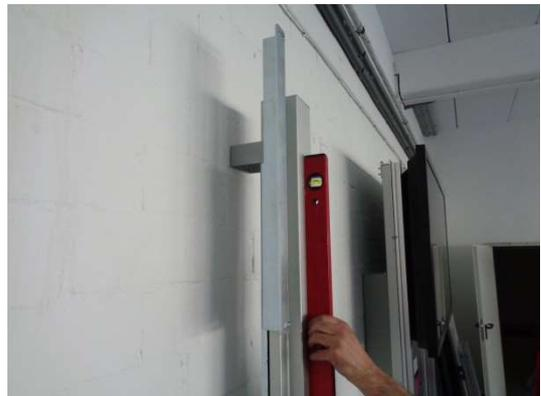
Nun die Pylone mit den 4 x Bohrschrauben  $\varnothing$  4,2 x 19 verschrauben.
